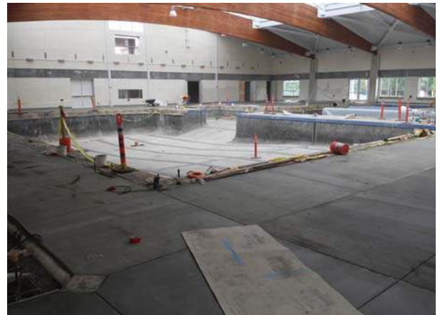
Natorium Deck Pour
